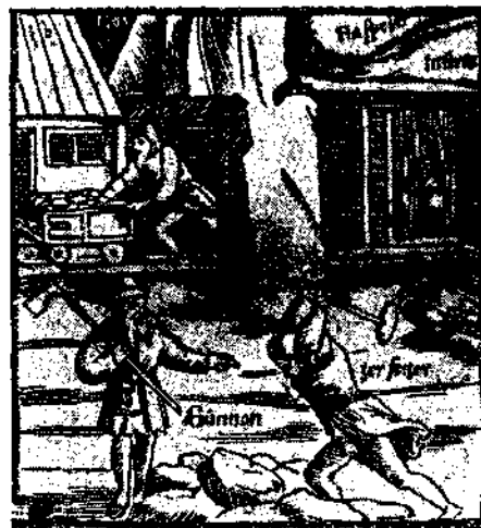
Рис. 1. Деревянная дорога в немецких рудниках в XVI столетии
