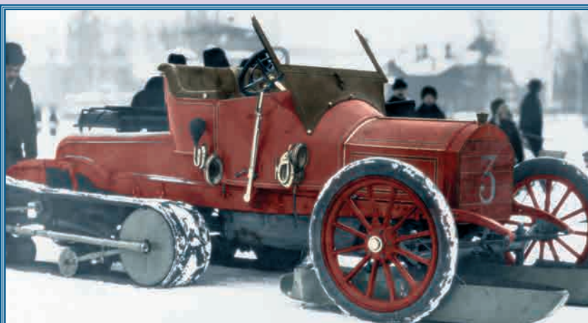
Автомобиль «мерседес» из гаража российского императора, оснащённый гусеничным движителем конструкции А.А. Кегресса на старте гонки Петербург — Кронштадт — Петербург 1913 г.
